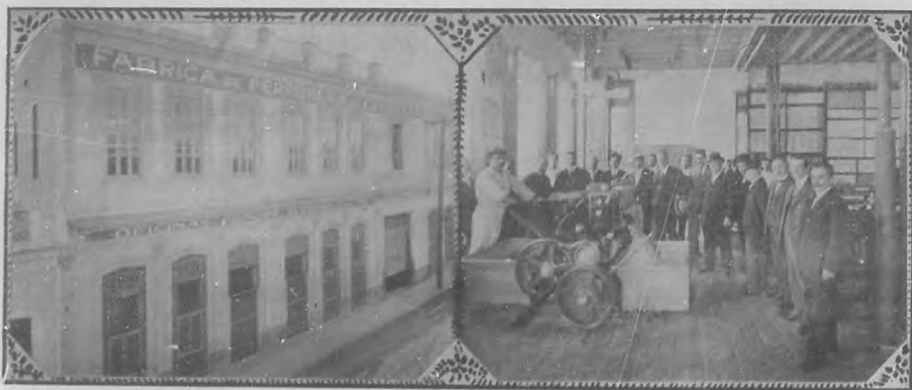
Frete del nuevo local, en el edificio propiedad de los señores Crusellas, que da a la calle Estévez.—Visitantes, los empujados de los dueños de la fábrica, viendo funcionar una máquina de elaborar jabón fino.
